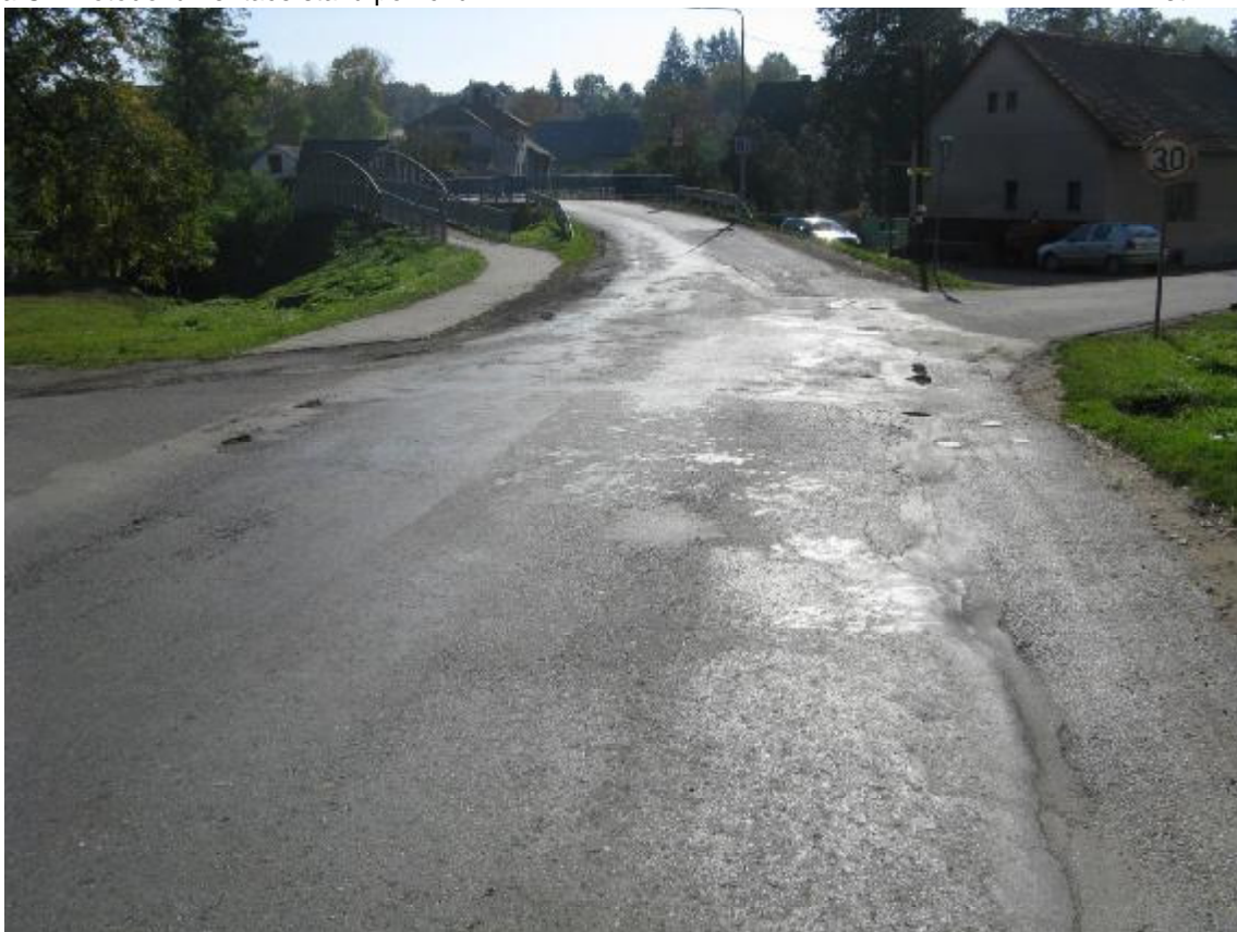
F02, km 0,410+ Vpravo vysrávky s deformacemi a výtluky.
