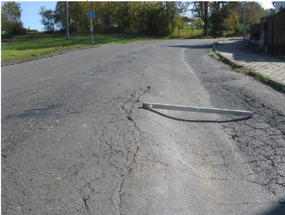
F11B, km 0,700+ Plošné deformace a síťové trhliny.
