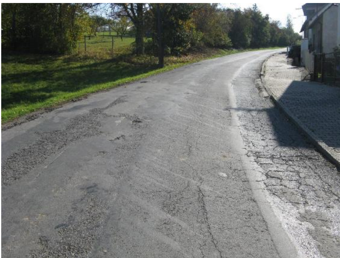
F13, km 0,720+ Vpravo zapravená rýha s plošnými deformacemi a síťovými trhlinami, zbývající vozovka s korozí a vysprávkami.
